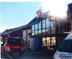
Depuis quelques temps, des fuites et des infiltrations se produisaient dans la verrière de la mairie. Les établissements Ducrot ont été contactés pour procéder à une réfection des joints et à un nettoyage complet. L'avenir nous dira si des travaux d'envergure sont à prévoir.
