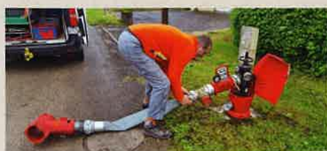
Contrôle du débit des poteaux d'incendie
